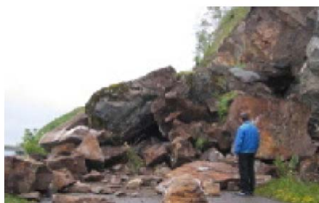
Kaivegen på Rødøy har hatt flere steinras de siste åra. Bildet er fra et av rasene i 2004.
