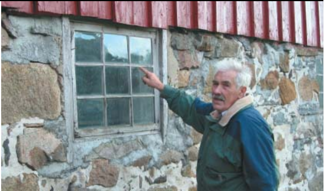
Petter Haagensen viser fram detaljer i restaureringsarbeidet av fjøsen.
