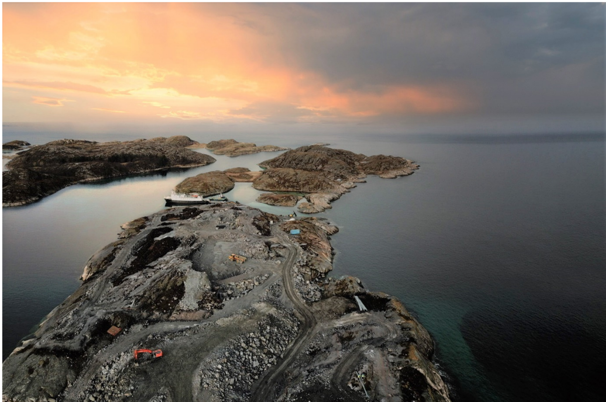
Figur 10. Lille Indre Rosøya med Store Indre Rosøya i bakgrunnen. Utsprengning av bassengene er i gang. Sett fra syd. Foto Gigante Salmon Rødøy mars 2022.
