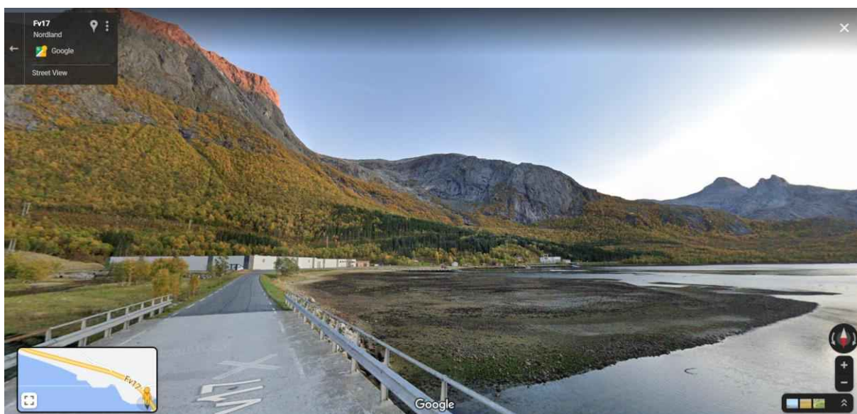
Figur 10. Området ved Reppaelvas utløp – sett fra Reppaelva bru mot sør. Eksisterende anlegg for Helgeland Smolt og Reppa kraftstasjon i bakgrunnen. Kilde; Google maps.
