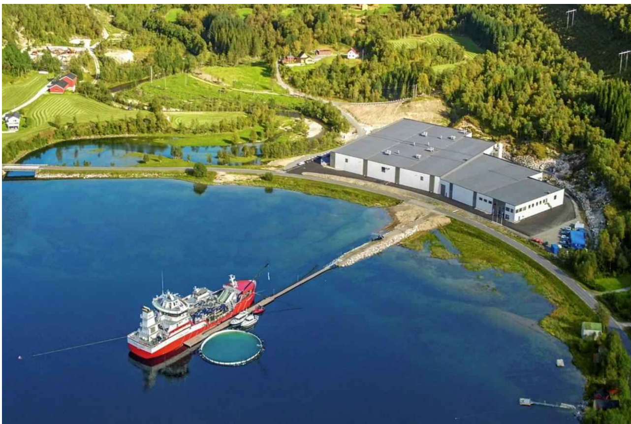
Figur 3. Dagens anlegg- flyfoto mot sørøst. Foto: Helgeland Smolt AS.
