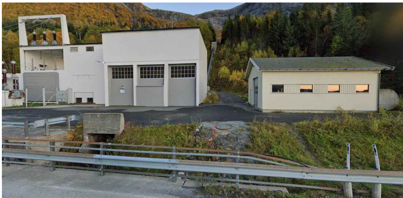
Figur 8-1 Reppa kraftstasjon med rørgate i bakgrunnen. Kilde: Google Maps street view
