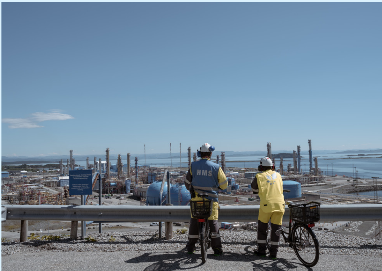
Kårstø-anlegget i Tysvær kommune. (Foto: Equinor)
