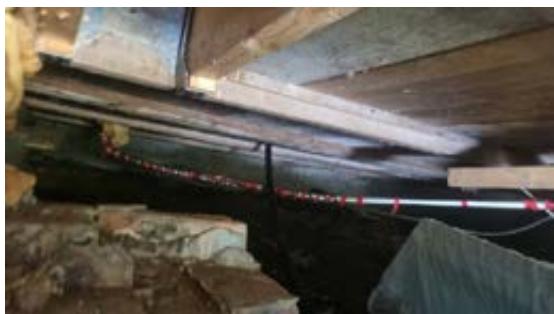
Inspeksjon av kryptkjeller.
