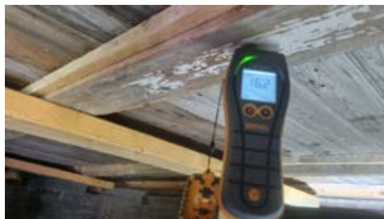
Fuktmåling i stubbloft, ingen unormale fuktverdier ble registrert.
