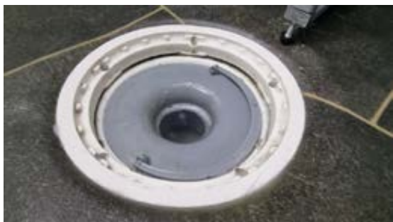
Kontroll av sluk.
