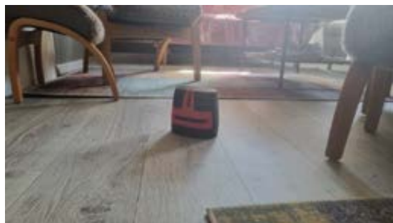
Kontroll av planavvik/skjevheter i gulv med krysslaser.
