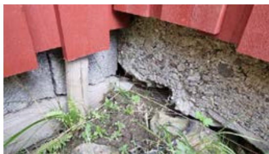
Delvis undergravd under grunnmur.
