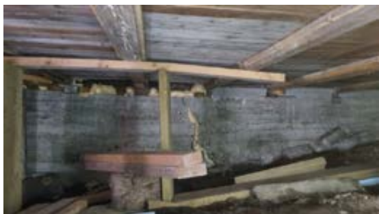
Provisoriske understøtter av tre i krypkjelleren.
