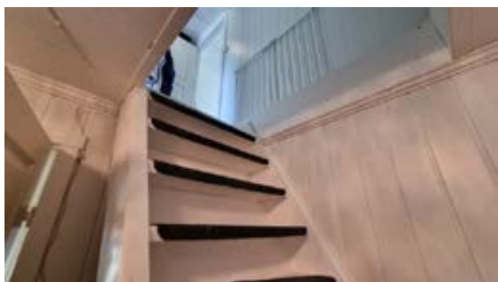
Bratt trapp til loftsetasjen.
