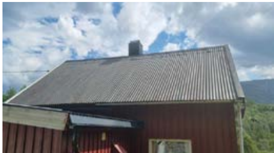
Visuell besiktelse av taket.
