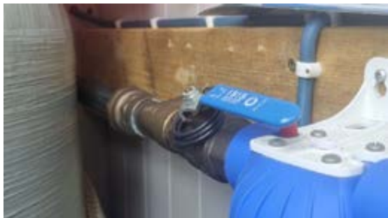
Kontroll av innvendig hovedstoppekran.
