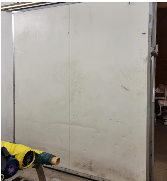
Bilde 20: B1, 1. etg. rom 3. Kjøleromsdør.
