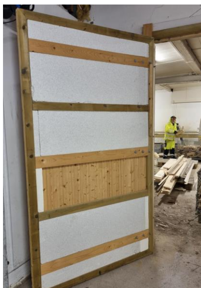
Bilde 30: B2. Impregnert trevirke.
