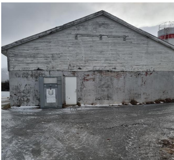
Bilde 5: Fasade mot vest.
