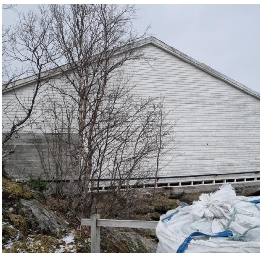
Bilde 8: Fasade mot øst.
