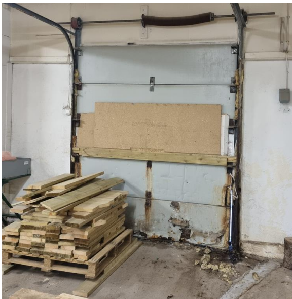
Bilde 26: B1, 1.etg, rom 7. Garasjeport.
