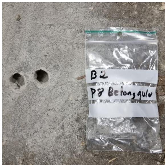
Bilde 13: B2, P8, betong i gulv.
