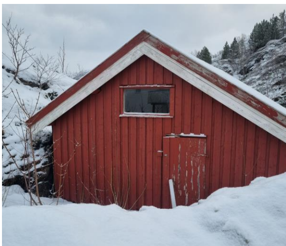
Bilde 1: Fasade mot nord-vest
