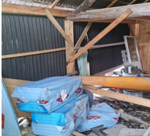
Bilde 4: Vegg mot nord-øst dekket med Onduline.
