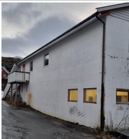
Bilde 2: Fasade mot øst.
