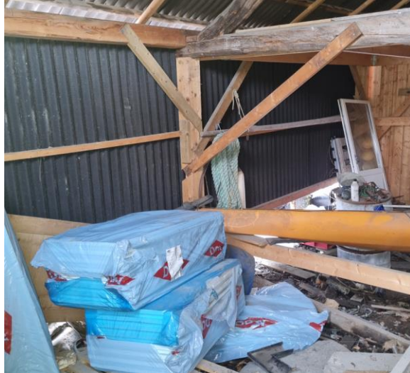
Bilde 4: Vegg mot nord-øst dekket med Onduline.
