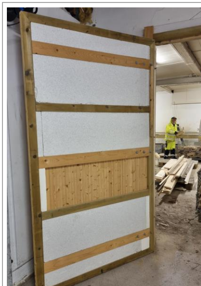
Bilde 30: B2. Impregnert trevirke.
