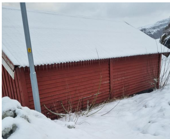
Bilde 2: Fasade mot sør-vest
