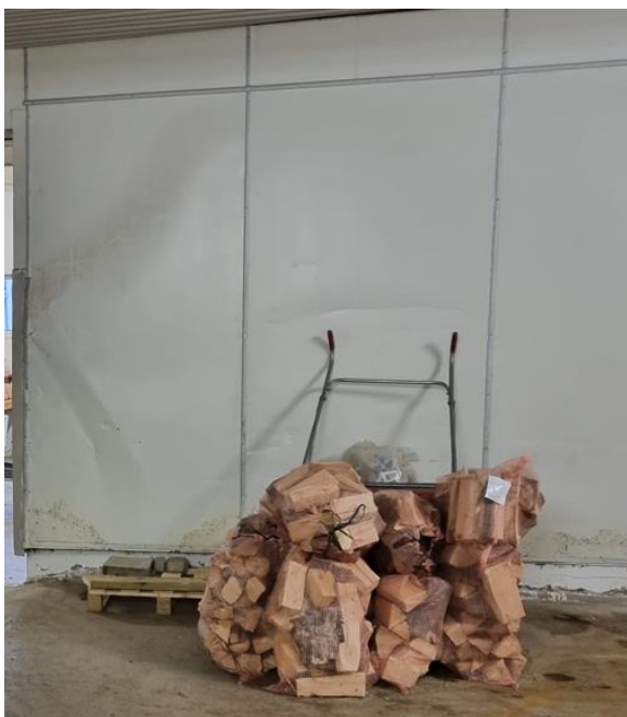
Bilde 22: B1, 1. etg, rom 4. Veggplater med isolasjon.
