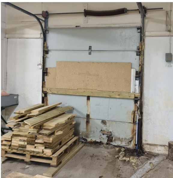
Bilde 26: B1, 1.etg, rom 7. Garasjeport.
