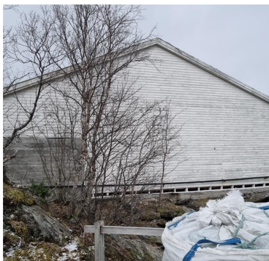
Bilde 8: Fasade mot øst.
