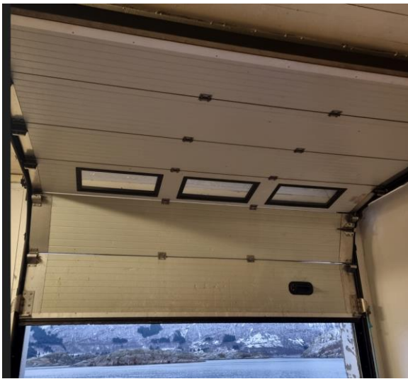
Bilde 24: B1, 1. etg, rom 6. Garasjeport.
