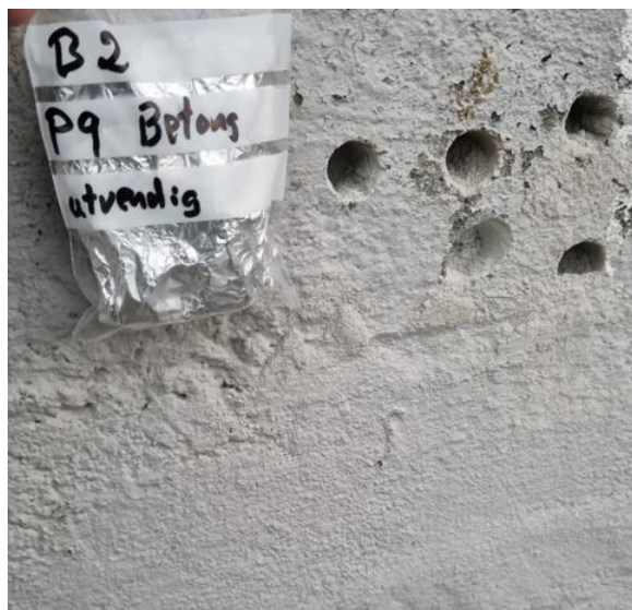
Bilde 14: B2. P9. betong utvendig vegg.
