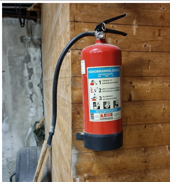
Bilde 29: B2. Brannslukker, pulver.
