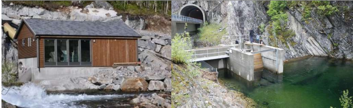
Bilde 2: Kistafossen kraftverk er etablert i Østerdalselva.
