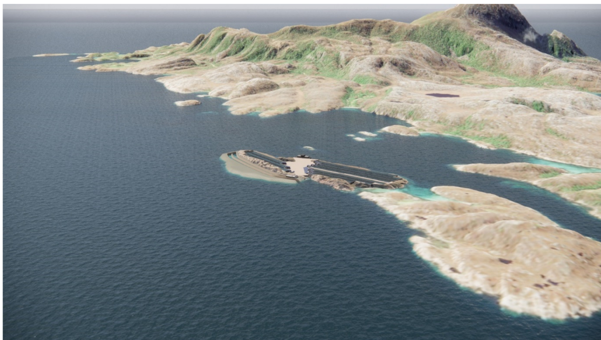
Figur 21. Anlegget sett fra NØ. Utfyllingsområde på østsiden av øya, midt på bildet. BOARCH arkitekter a.s februar 2022.
